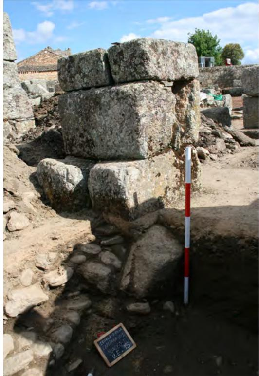
**Figura 13.** Pilar de la arquería interna del edificio interpretado como iglesia en el Paço dos Bispos. La estructura tardoantigua se apoya en un muro de cantos rodados de cronología bajoimperial con orientación norte-sur (© autora).
