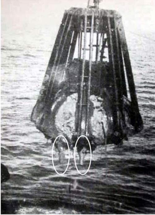
**Figura 4.** Draga del Artiglio utilizada por Lamboglia en 1950 para recuperar el cargamento del pecio de Albenga. Obsérvese en la parte inferior de la draga, marcados con óvalos, el tercio inferior de dos ánforas Dressel 1 (imagen en Lamboglia, 1952, fig. 8).
