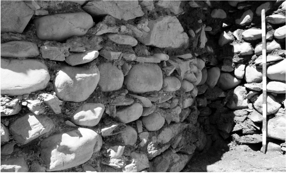
Fig. 8. Morfología de la fábrica del cimio del ábside sur.
