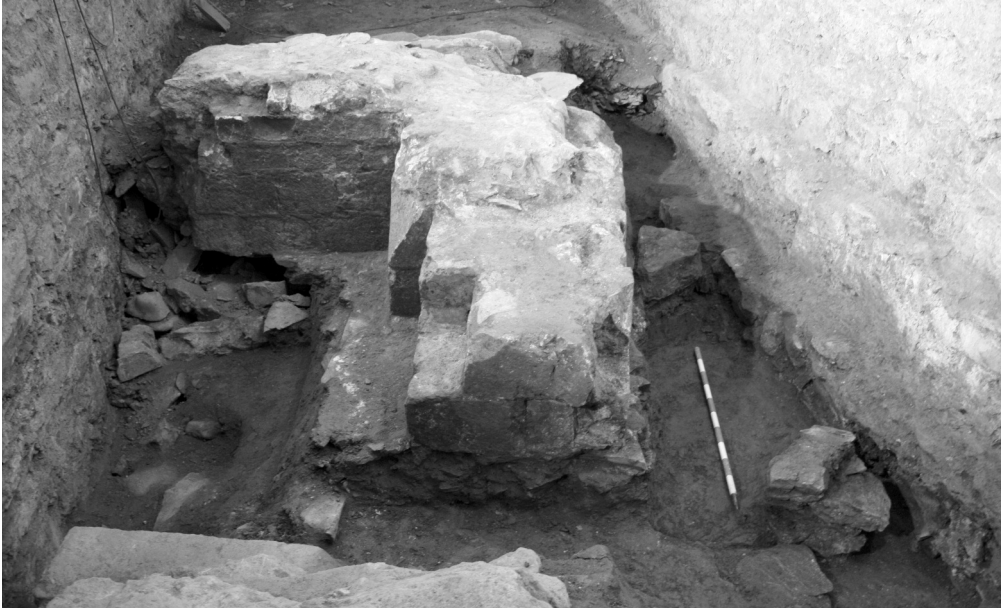
Fig. 3. Detalle de la dependencia adosada a la esquina sureste. Se aprecia la fábrica de sillería y restos del suelo de mortero.
