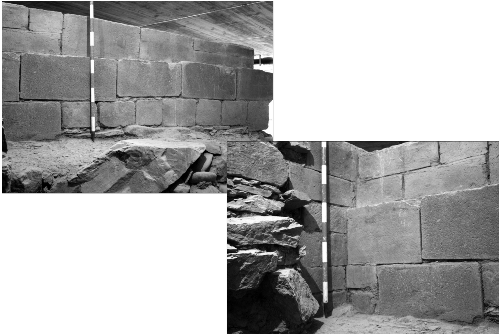
Fig. 5. A-B. Fábrica de sillaría conservada en el paramento exterior occidental del transepto sur.
