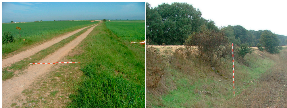
Fig. 7. La vía romana entre las mansiones Tritium (Tricio) y Libia (Herramélluri) en La Rioja: superficie de rodadura actual (izquierda) y aspecto de uno de los terraplenes (derecha).
