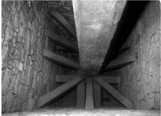
Fig. 25. Premsa de biga del 1757 amb taissons ancrés localitzada a Coulanges-La-Vineuse (Yonne, Bourgogne) (J.L. Duthu © Inventaire général, ADAGP, 2003) (Lauvergeon, 2004: 14, fig. 14).
