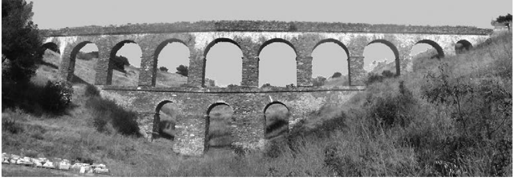
Fig. 8. Acueducto III (imagen: Elena Sánchez).
